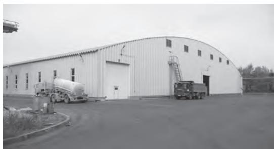
**Рис. 11.** Бескаркасное здание типа Honco
