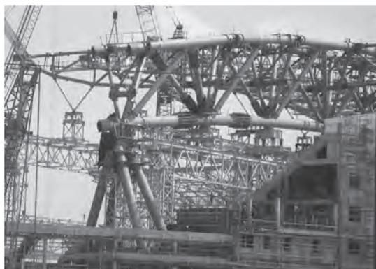
**Рис. 2.** Электросварные прямошовные трубы в конструкциях футбольного стадиона в Казани
