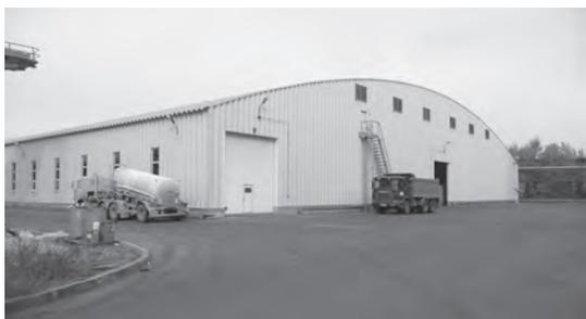
**Рис. 11.** Бескаркасное здание типа Нонсо
