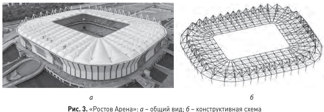
**Рис. 3. «Ростов Арена»: *а* – общий вид; *б* – конструктивная схема**
