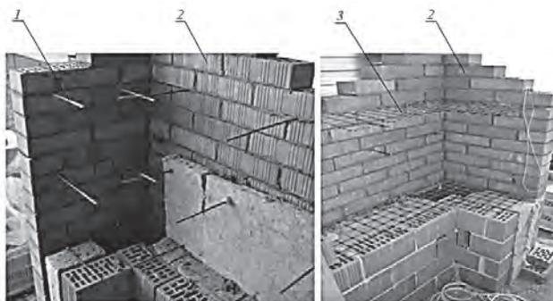
**Рис. 8.** Фрагменты стен модели: 1 – гибкая связь из одиночных стержней; 2 – лицевой слой из керамического кирпича; 3 – гибкая связь из сетки
