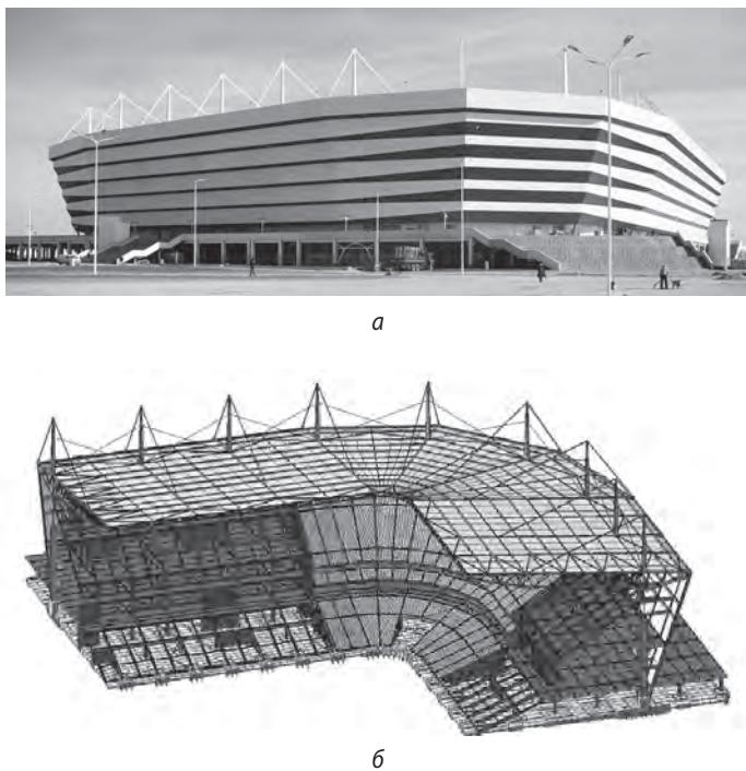
**Рис. 4.** «Стадион Калининград»: *а* – общий вид; *б* – конструктивная схема
