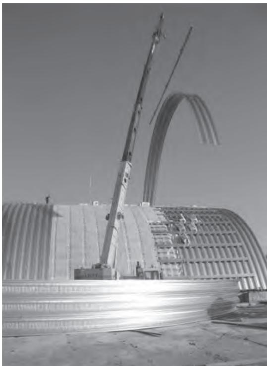
**Рис. 8.** Конструкция двухслойного арочного зданий из ХГП корытного типа
