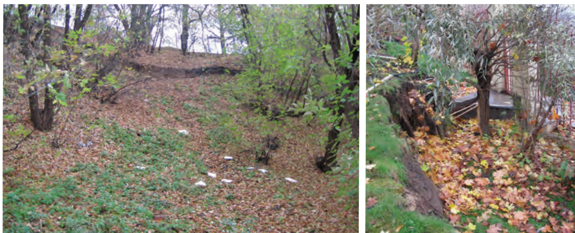
Рис.2. Характерные проявления оползня. На фото справа видно разорванное оползнем дерево на территории поселка
