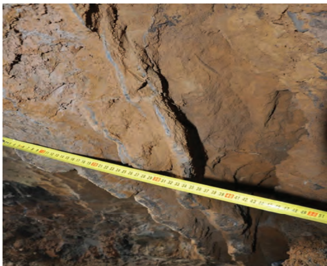
Рис.1. Вертикальные и наклонно направленные разрывы цементным раствором
