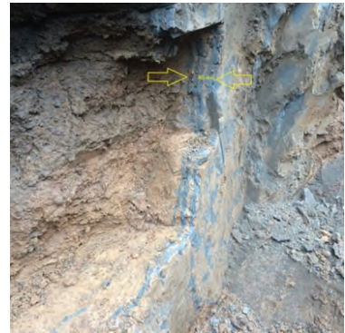
Рис.5. Толщина трехслойной (по числу закачек) мембраны 40 мм
