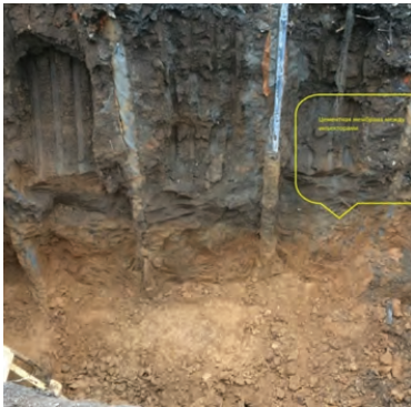
Рис.3. Вид откопанных инъекторов. Внизу отчетливо видна сплошная цементная мембрана между инъекторами
