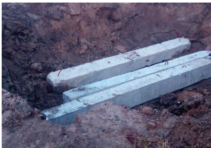
Рис.2. Общий вид котлована (первый нижний ряд труднопробиваемой прослойки из «отходов» свай)
