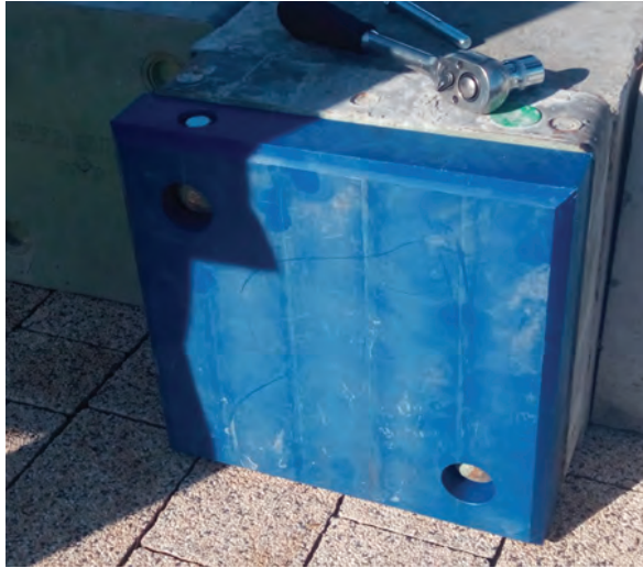
Рис.3. Съемный ударпрочный оголовок из полиуретана для сохранности стыка
