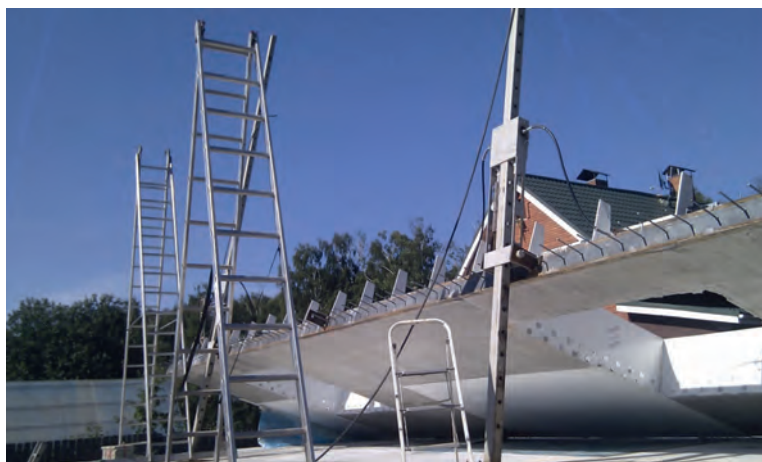
Рис. 1. Подъем стеновой панели на фундамент
