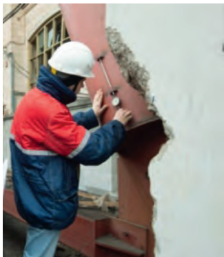
Рис. 14. Измерение деформаций в вертикальных связях во время реконструкции
