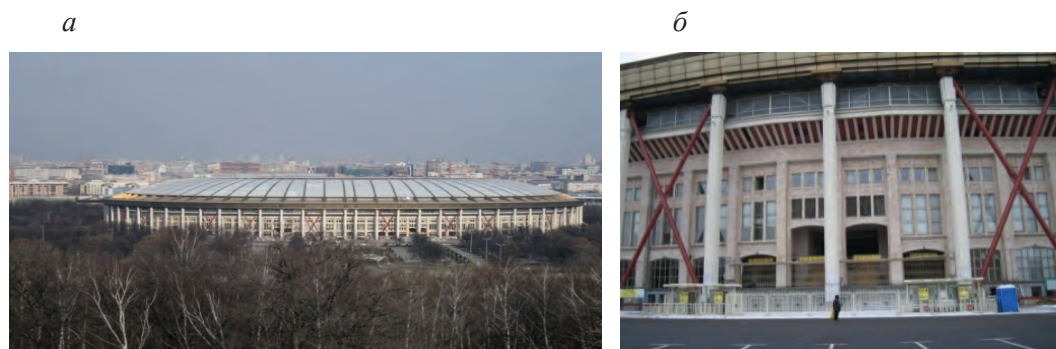
Рис. 9. Временные вертикальные связи между существующими колоннами БСА: а — общий вид стадиона с временными связями; б — временные вертикальные связи из труб
