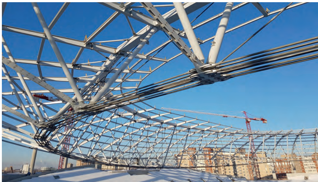
Рис. 3. Конструкции из труб высокой прочности при строительстве стадиона «Динамо» (ВТБ-Арена) в г. Москва
