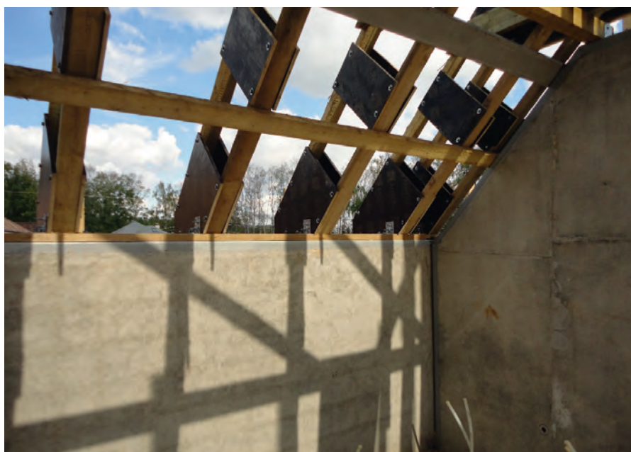
Рис. 5. Вид монтируемых панелей «изнутри»
