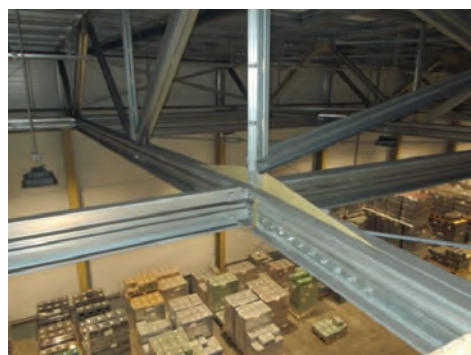
Рис. 4. Стропильные фермы покрытия здания склада: а — верхние пояса ферм; б — нижние пояса ферм
