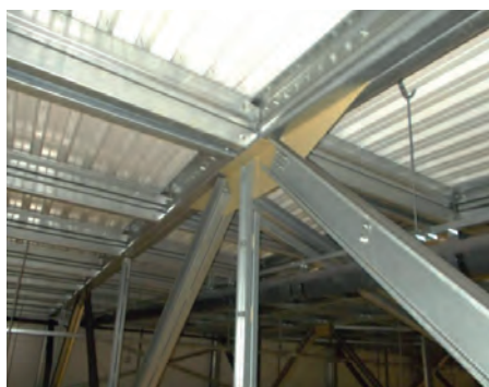
Рис. 4. Стропильные фермы покрытия здания склада: а — верхние пояса ферм; б — нижние пояса ферм
