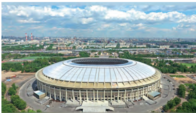
Рис. 15. Общий вид реконструированной арены БСА «Лужники». Вид снаружи
