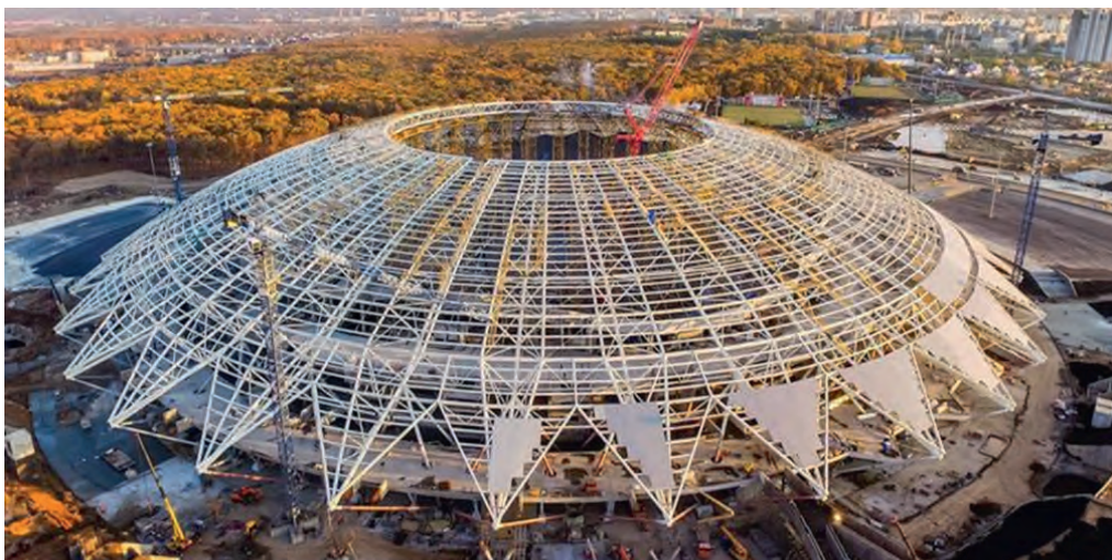
Рис. 5. Конструкции из труб высокой прочности при строительстве стадиона «Самара Арена» в г. Самара
