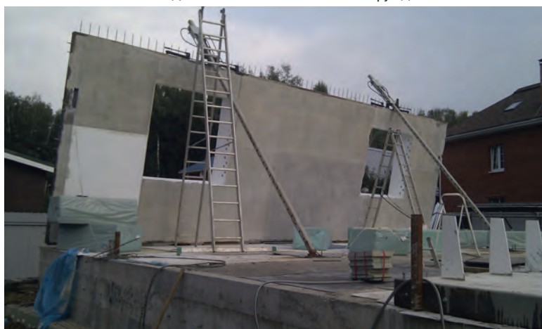
Рис.2. Подъем монолитной панели на завершающем этапе
