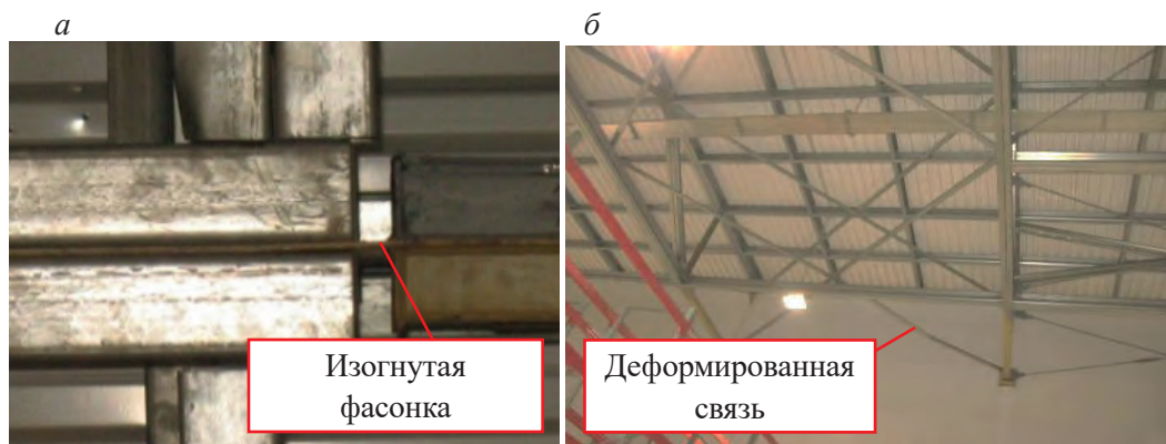
Рис. 8. Повреждения элементов в процессе эксплуатации: а — изогнутая фасонка; б — деформированная связь
