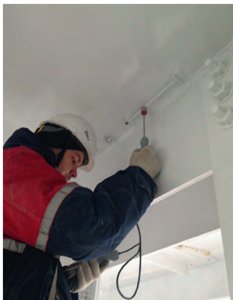
Рис. 13. Измерение температуры конструкции контактным термометром ТК 5-01 П
