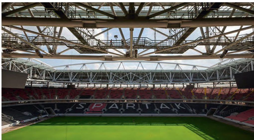
Рис. 4. Конструкции из труб высокой прочности при строительстве стадиона «Спартак» в г. Москва
