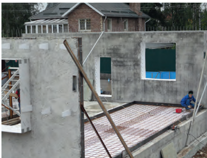
Рис.3. Временная фиксация поднятых стен в проектное положение. Укладка арматурной сетки в несъемную опалубку
