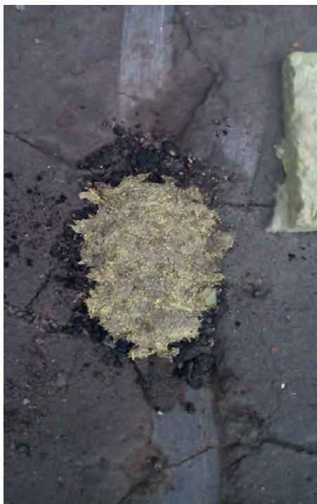
Рис. 3. Отремонтированная выбоина
