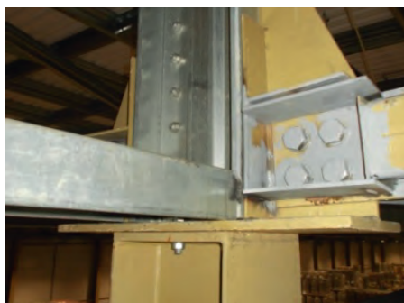
Рис. 5. Опираение нижнего пояса фермы и распорки на оголовок колонны по среднему ряду ( а ) и решение первого от опоры узла нижнего пояса фермы ( б )
