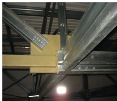
Рис. 5. Опираение нижнего пояса фермы и распорки на оголовок колонны по среднему ряду ( а ) и решение первого от опоры узла нижнего пояса фермы ( б )
