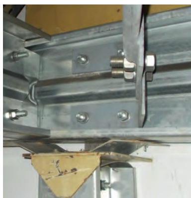
Рис. 7. Крепление нижнего пояса торцевой фермы к фахверковой стойке
