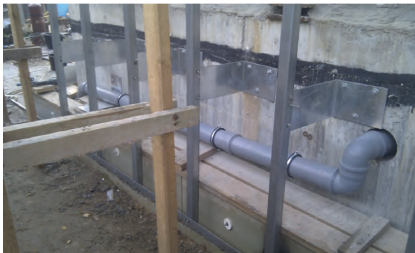
Рис. 6. Устройство фасада из керамогранитных плит
