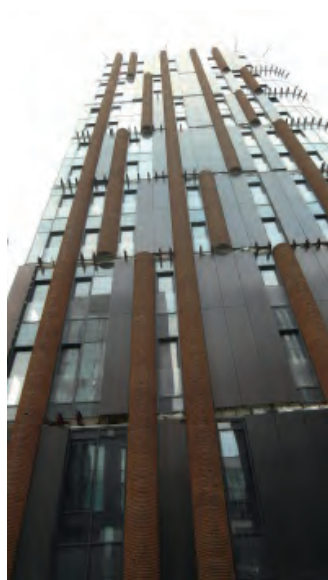
Рис. 2. Здание с кирпичной облицовкой
