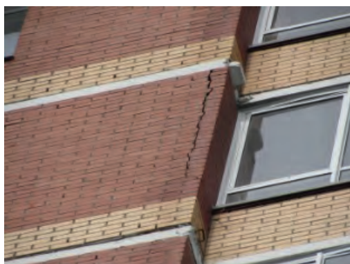
Рис. 4. Трещина в лицевом кирпичном слое
