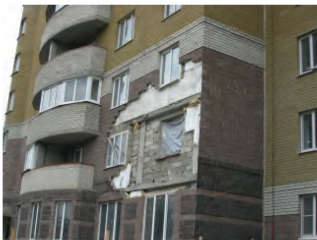
Рис. 8. Обрушение кирпичной облицовки
