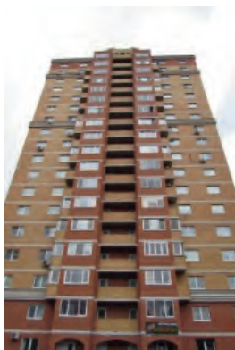
Рис. 10. Многослойная конструкция с поэтажным опиранием
