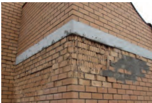
Рис. 6. Повреждение кирпичной облицовки на фасаде
