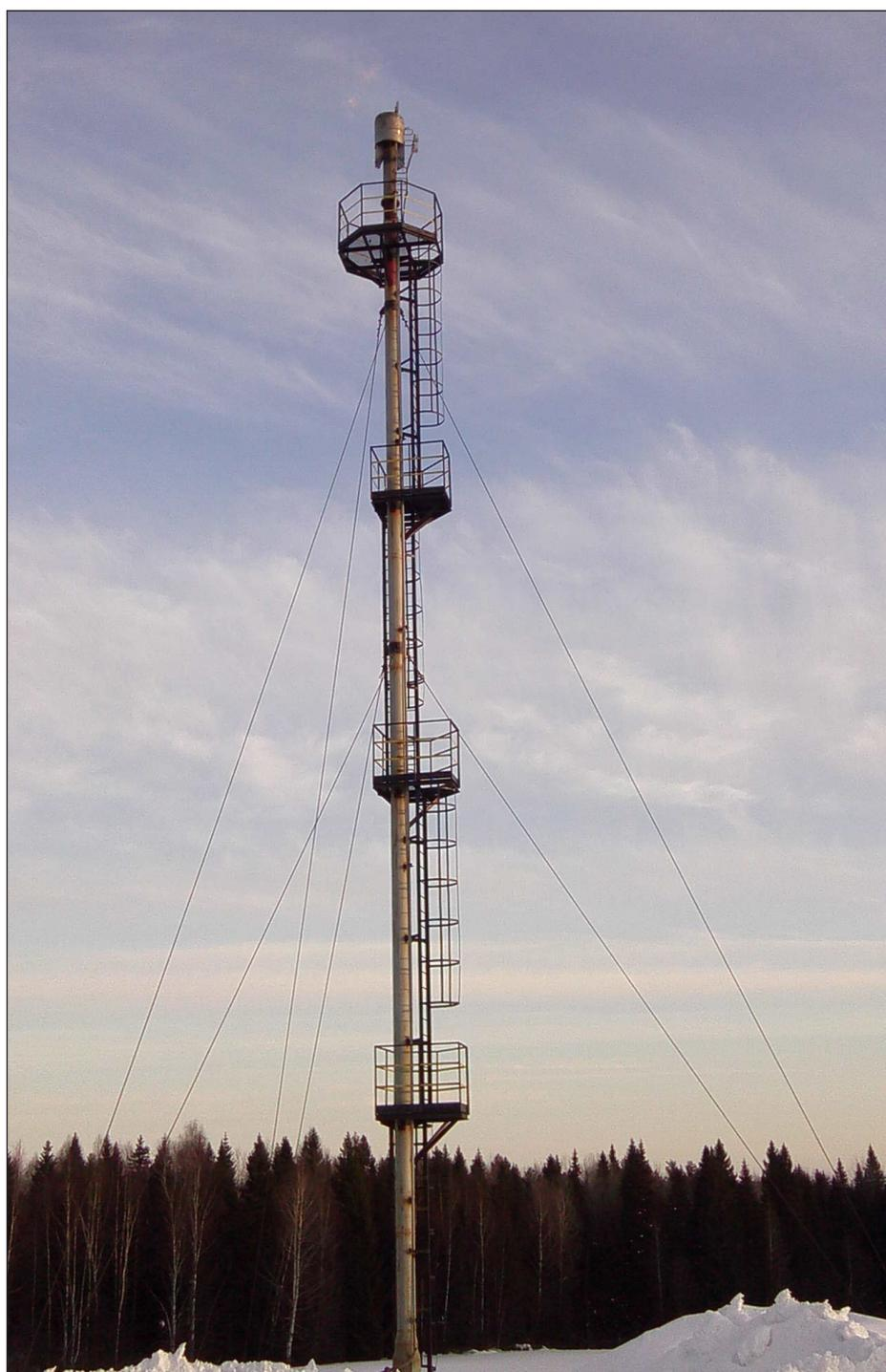
разработана универсальная установка на базе факельных оголовков типа ФОКГ.
