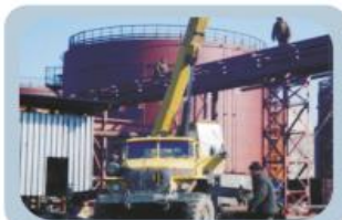
Нефтяные перегрузочные центры
