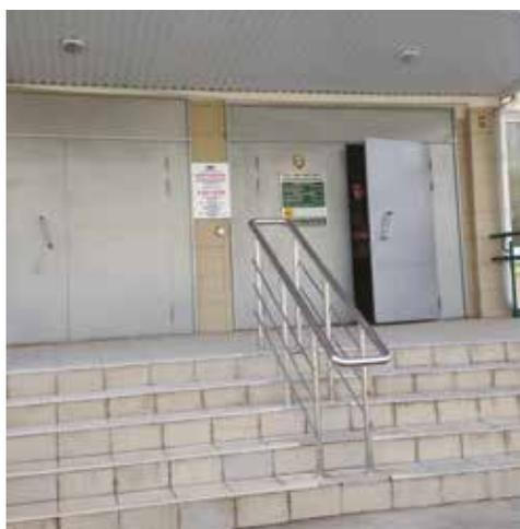
Рисунок 2.40. Лестница шириной более 4 м с установленными посередине ограждениями с поручнями
