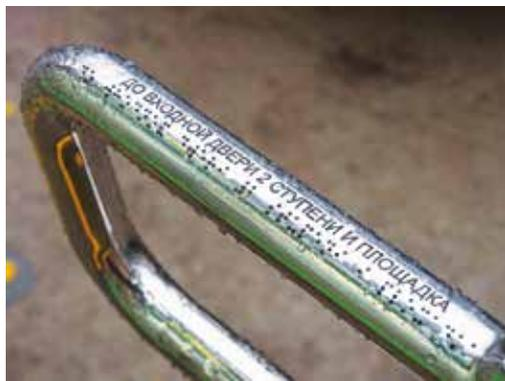
Рисунок 6.19. Информация рельефно-точечным шрифтом Брайля и тактильными буквами на поручнях лестниц
