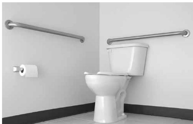
◀ Рисунок 5.4. Туалетная комната с унитазом, размещённым в углу, и горизонтальными стационарными поручнями. Схема дана по ГОСТ 51261 [31]
