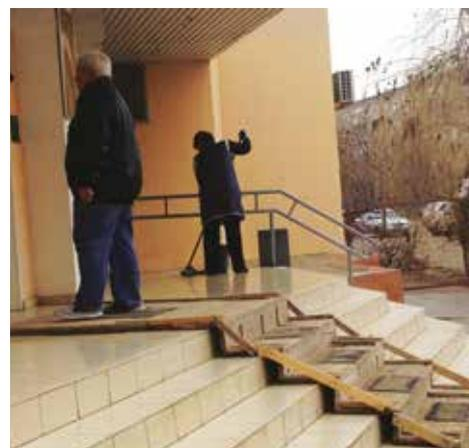
Рисунок 2.21. Центр занятости населения, г. Волжский. На крыльце входа в холодное время года смонтирован деревянный настил, так как покрытие лестницы и входной площадки крайне скользкое
