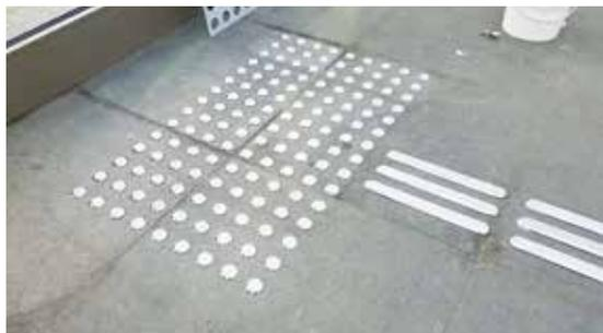
Рисунок 6.46. Пример размещения тактильных индикаторов на поверхности
