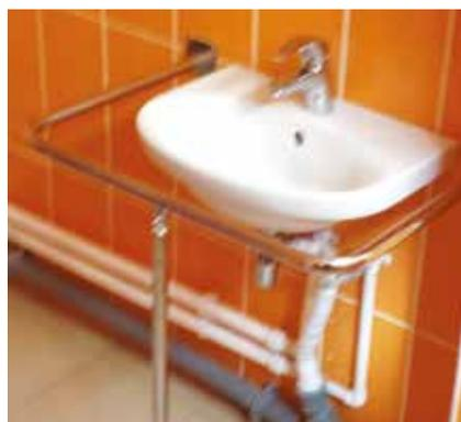
◀ Рисунок 5.23. Слева: поручень установлен настолько далеко от раковины, что даже обычному человеку тяжело дотянуться до крана. Справа: опорная стойка поручня препятствует фронтальному подъезду человека на инвалидной коляске
