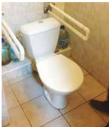
Рисунок 5.9. Театр юного зрителя, г. Волгоград. Поручни возле унитаза в нарушение требований ГОСТ 51261 [31] не выступают за его пределы
