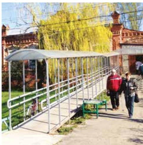
Рисунок 2.33. Поликлиника Центральной районной больницы, г. Елань. Пандус, оборудованный навесом
