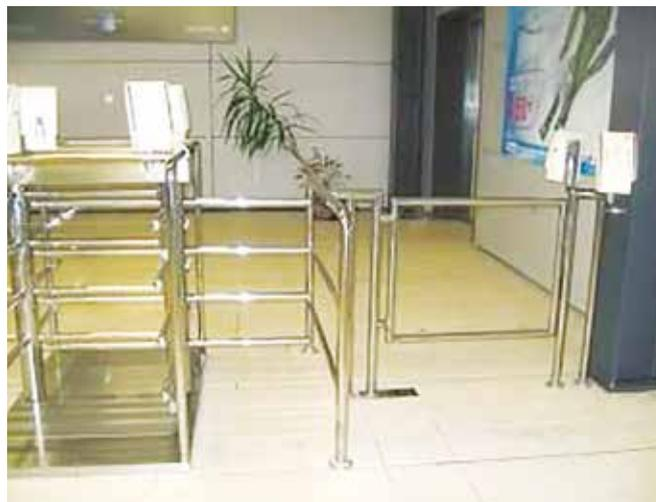
Рисунок 2.6. Калитки для проезда на кресле-коляске и прохода других МГН [44]
