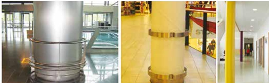
Рисунок 3.7. Примеры ограждения и/или контрастного обозначения колонн [44]
