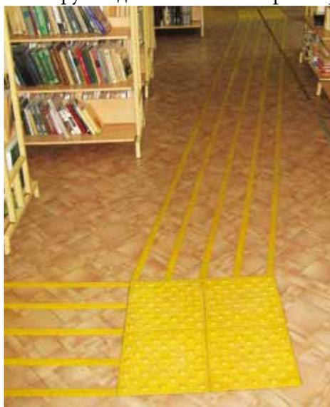
Рисунок 6.46. Пример использования тактильных лент в сочетании с тактильными плитами из резины
