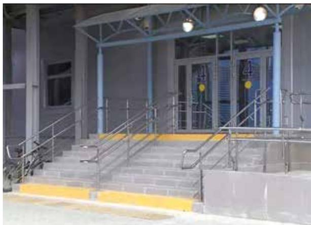
Рисунок 2.38. Лестница и пандус при входе в здание, оборудованные поручнями на высоте 70 и 90 см
