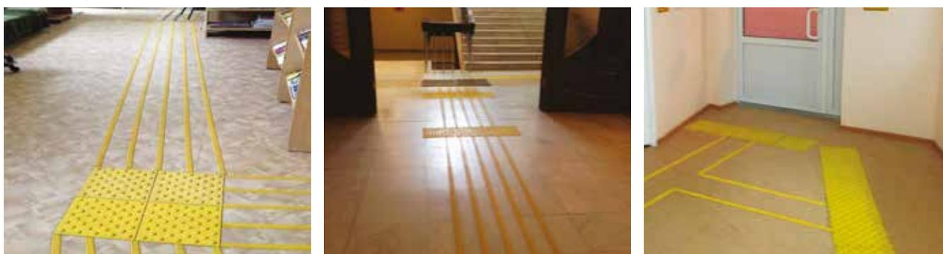
Рисунок 3.10. Примеры использования предупреждающих и направляющих тактильных указателей в здании
