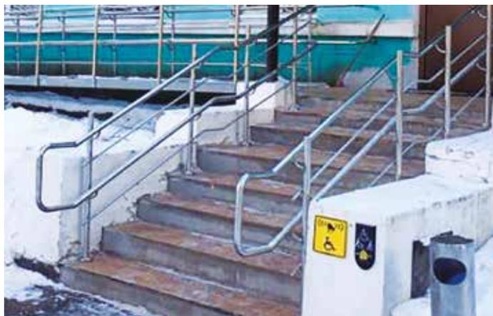
Рисунок 2.39. Лестница при входе в здание, оборудованная поручнями на высоте 50 и 90 см
