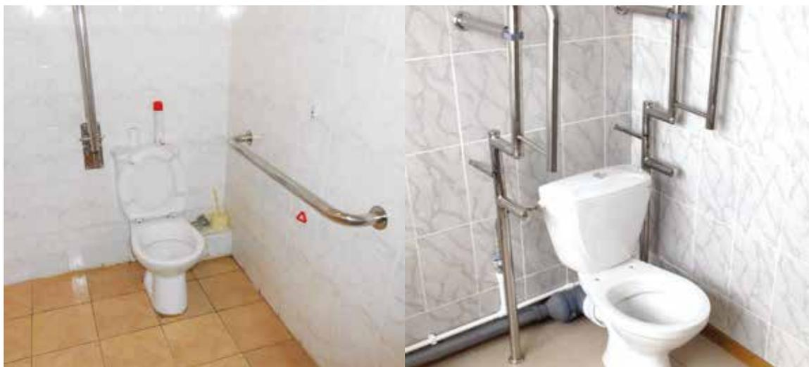
Рисунок 5.7. Слева: унитаз установлен в углу туалетной комнаты и оснащён горизонтальным стационарным поручнем (у стены) и откидным (со стороны подъезда кресла-коляски). Справа: унитаз установлен в углу туалетной комнаты и оснащён откидными поручнями. И тот и другой варианты допустимы
