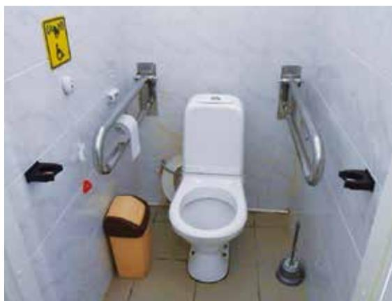
Рисунок 5.11. Стандартная туалетная комната, оснащённая поручнями, кнопкой экстренной связи и держателями для тростей
