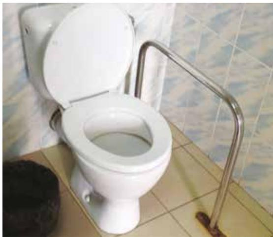
Рисунок 5.14. МФЦ, г. Елань. Неверная конструкция и высота установки поручня. Отсутствует второй поручень
