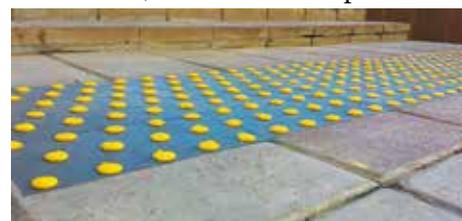
Рисунок 6.46. Пример использования тактильных лент в сочетании с тактильными плитами из резины
