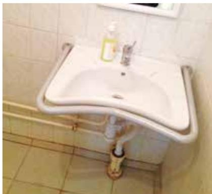
◀ Рисунок 5.20. Раковины оснащены поручнями, которые не препятствуют подходу/подъезду. Под раковинами имеется достаточно пространства для ног человека в инвалидной коляске
