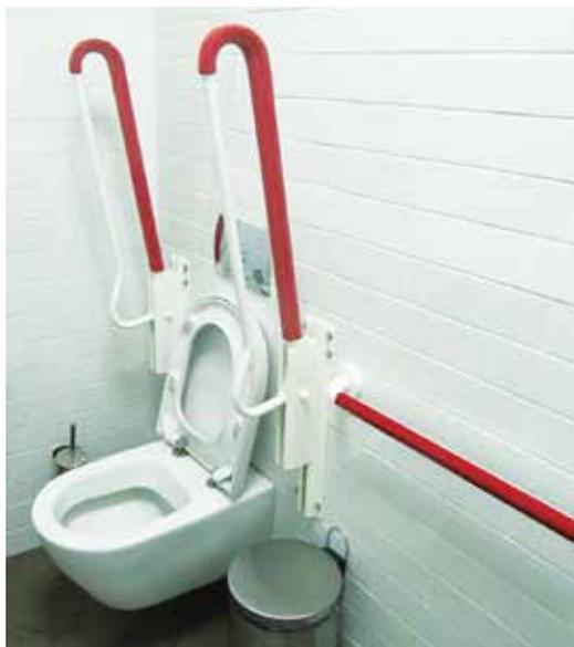
Рисунок 5.17. Унитаз установлен консольно и оснащён откидными поручнями по бокам
