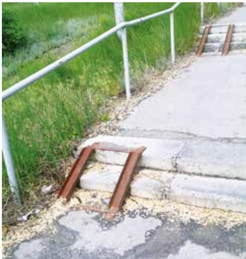
Рисунок 2.35. Металлические конструкции (аппарели), опасные для МГН, находятся на пути от остановки скоростного трамвая «Водоотстой»
