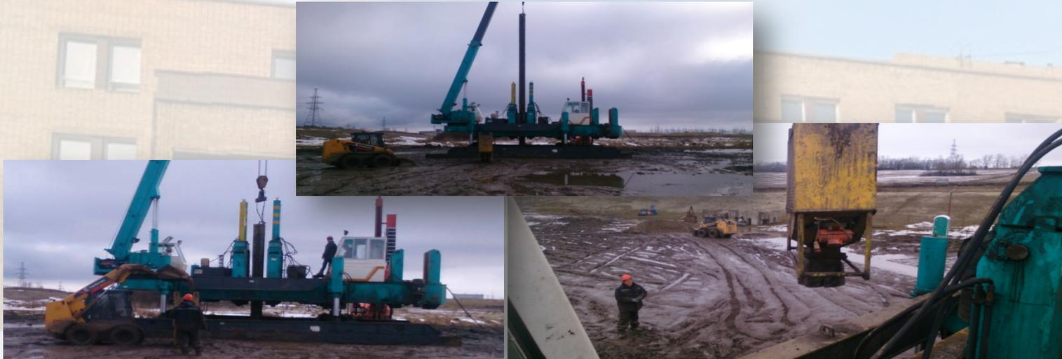
Выполнение НИОКР по теме: «Преобразование свойств слабонесущих водонасыщенных грунтов оснований основных и вспомогательных зданий и сооружений Курской АЭС-2 устройством грунтовых свай»
