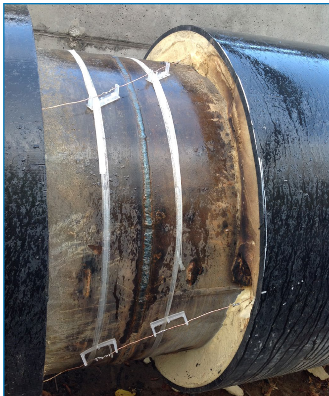
Рисунок 1. «Перекрученное» расположение проводников СОДК на трубопроводе.
