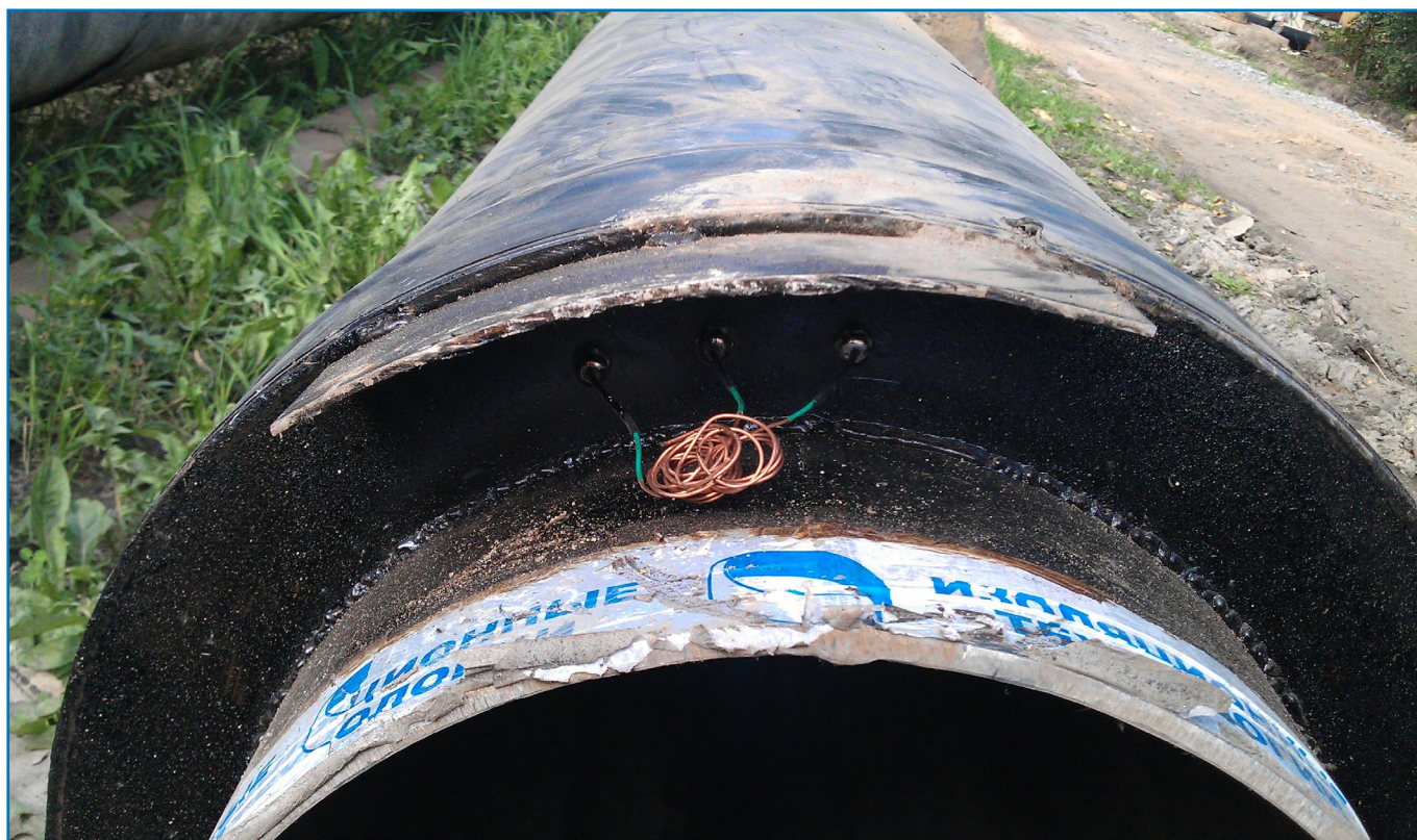
Рисунок 3. Концевой элемент с выводом непосредственно проводников ОДК.
