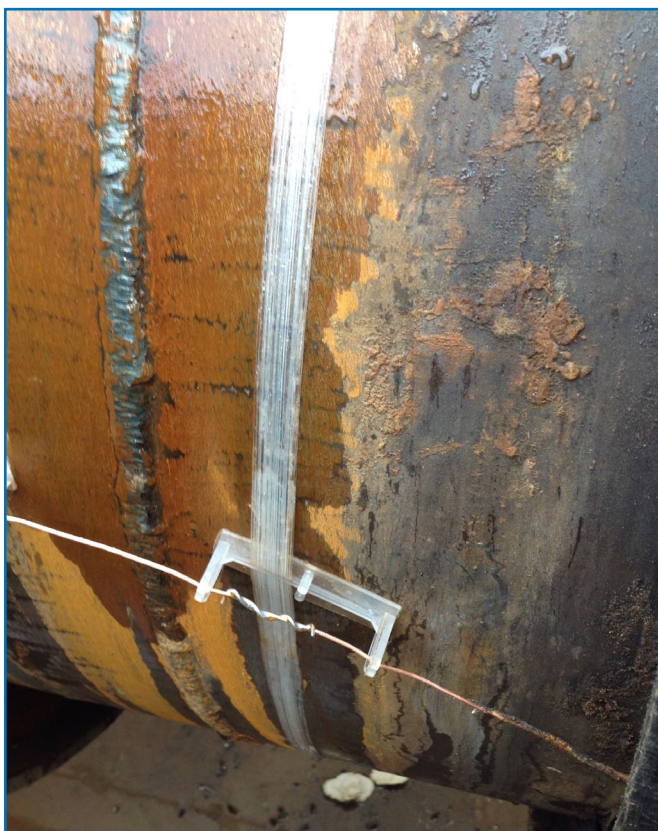
Рисунок 2. Соединение проводника на стыках труб.
