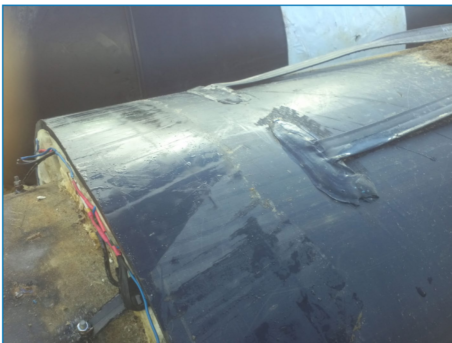
Рисунок 2. Место сварки кабеля в оболочку ППУ трубы.
